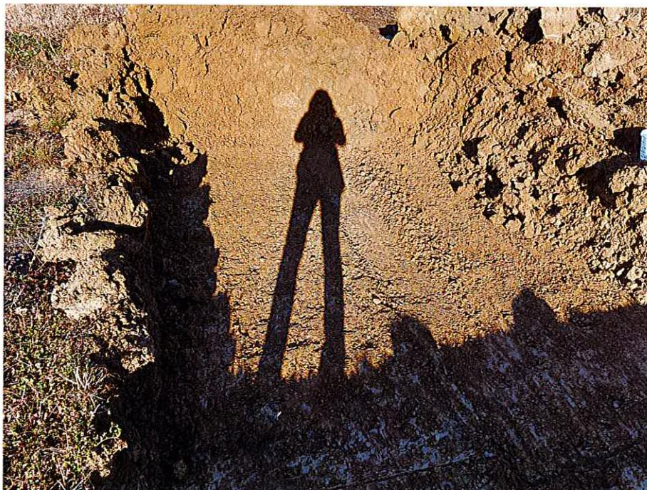
Abbildung 9: Sohle zusätzlicher Bodenabtrag im Bereich SP 5. Entnahme der Sohlproben SP 5a bis SP 5c.
